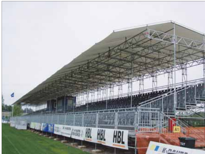
Tapiolan jalkapallostadionin katsomo. Hagalunds fotbollsstadions läktare.
